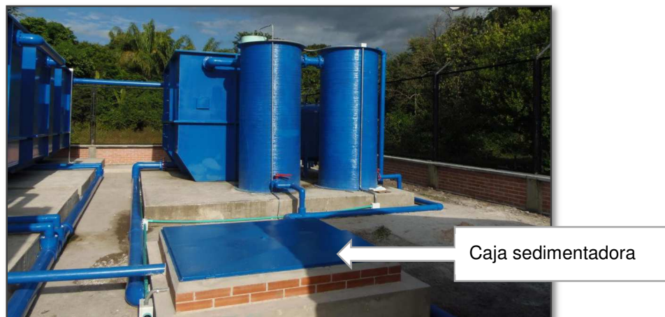
Imagen 10: Caja sedimentadora
