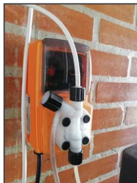
Imagen 12: Bomba dosificadora de cloro
