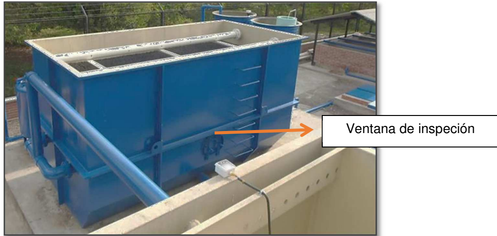
Imagen 9: Sedimentador
