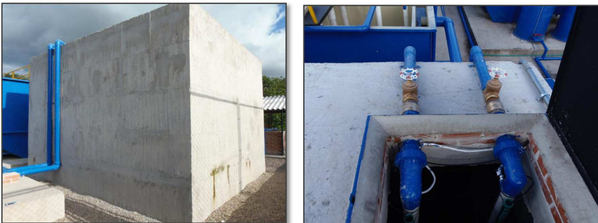
Imagen 5: Tanque Ecuilizador
